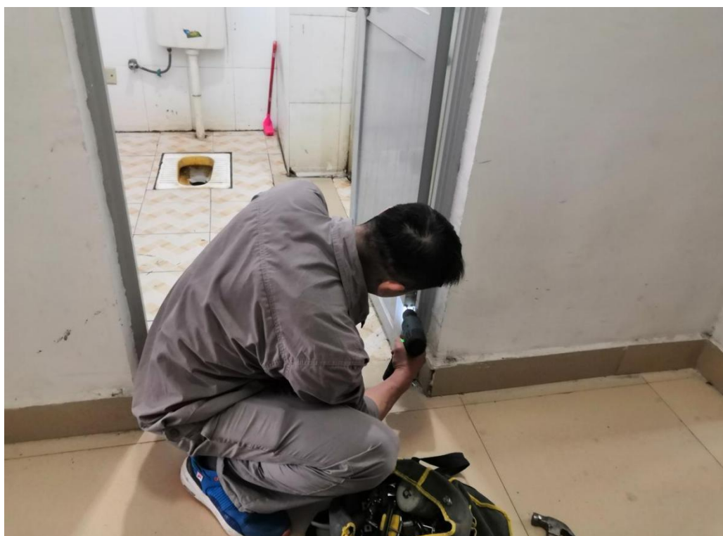
工程维修员对学生宿舍损坏的卫生间门进行维修
