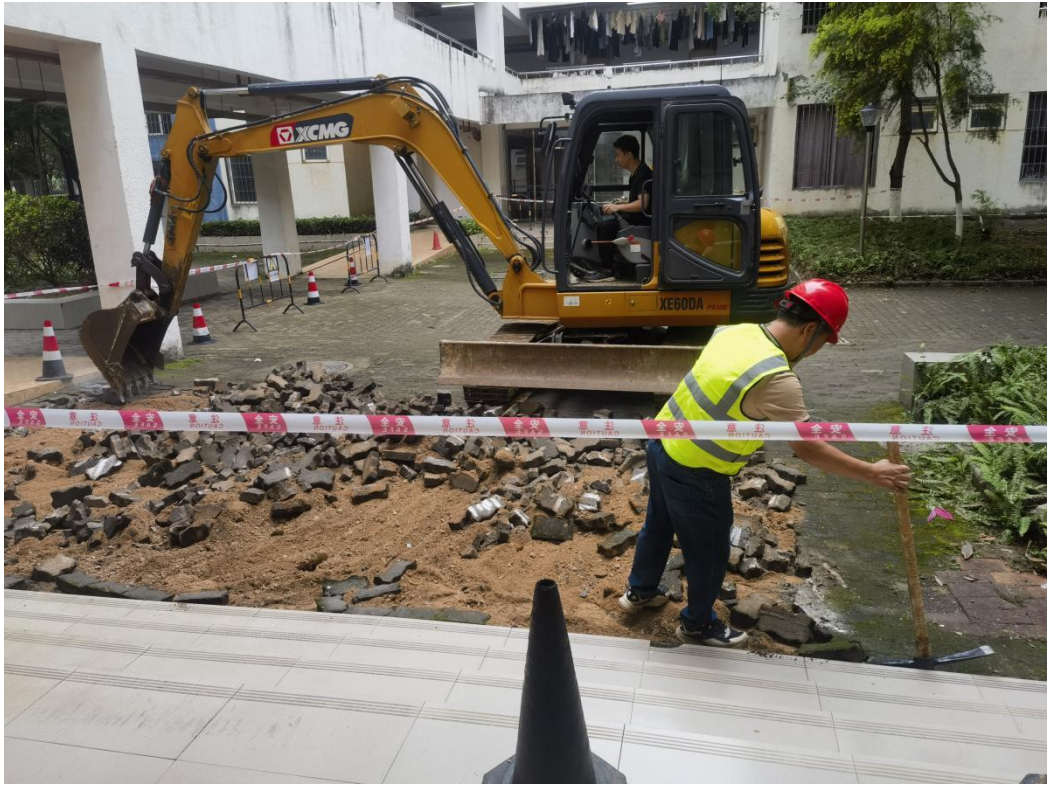
南校区第一实训楼北侧路面修复
