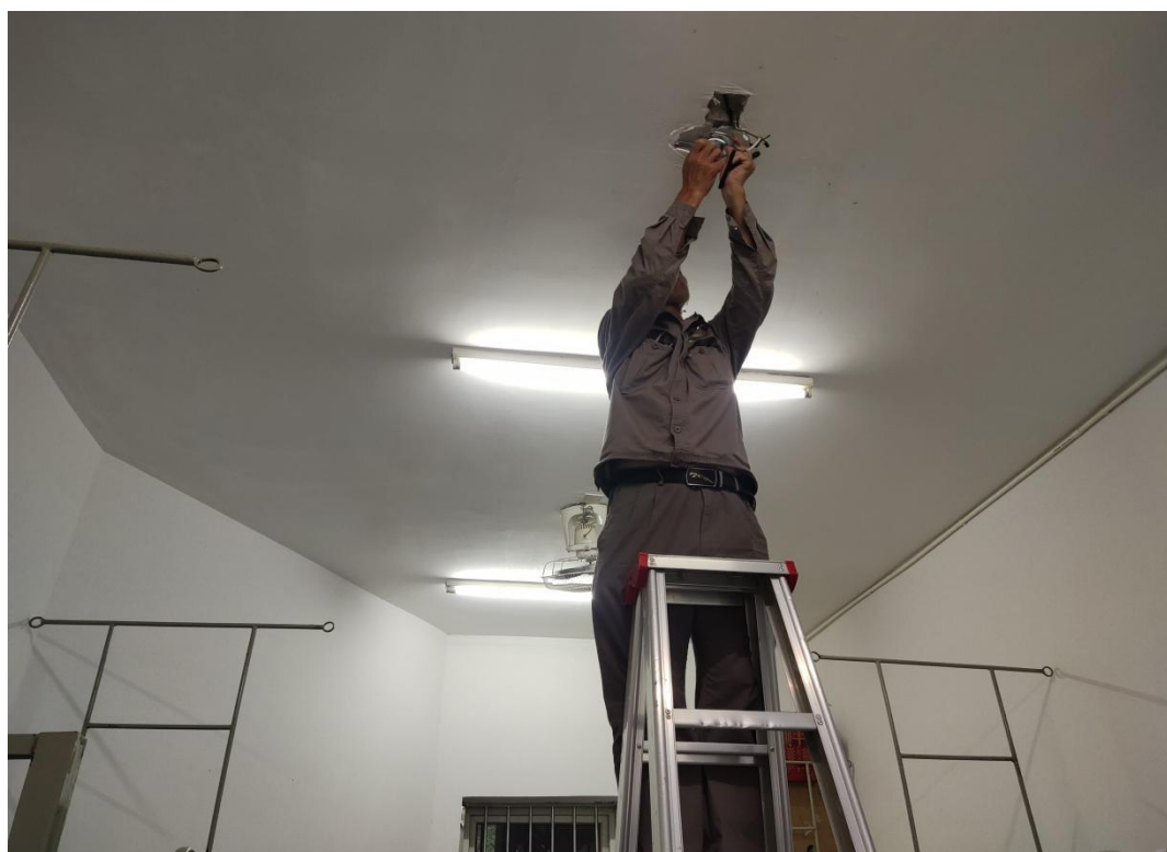
南校区工程维修员对学生宿舍损坏的风扇进行维修
