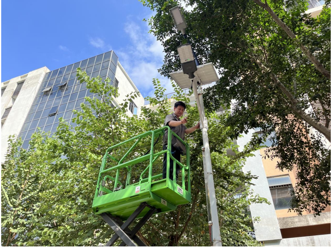
第二教学楼与第二实训楼之间安装太阳能灯
