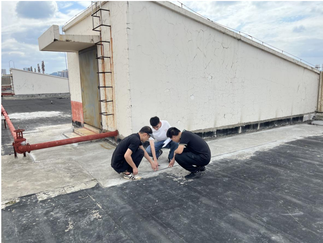
验收南校区图书馆楼顶补漏项目
