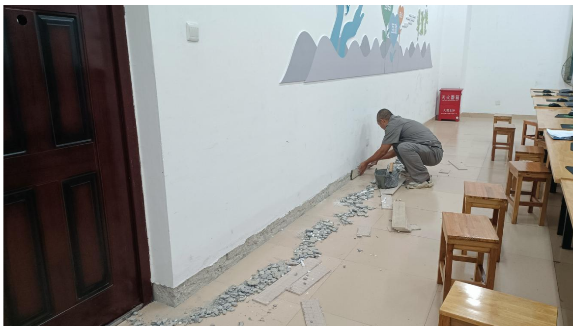
南校区物业翻修教室地脚线
