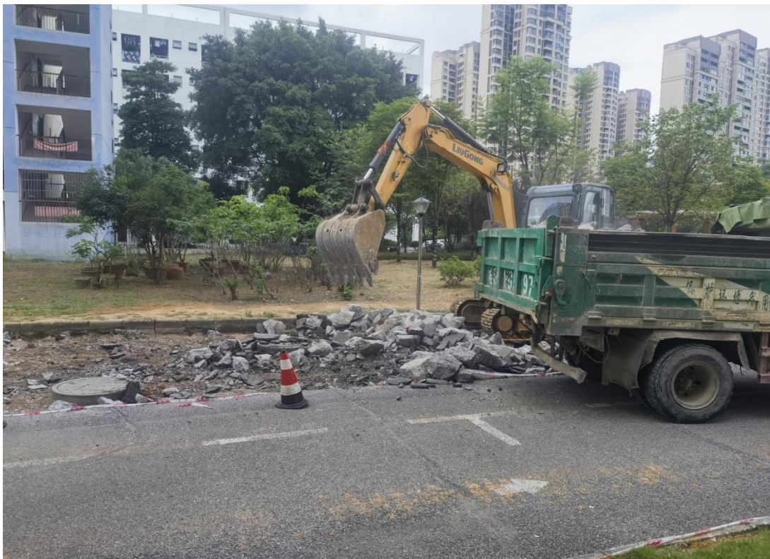
南校区第7栋宿舍楼路面修复
