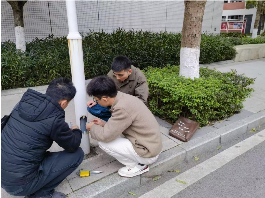
同审计处、施工单位对北校区弱电工程项目进行数据复核
