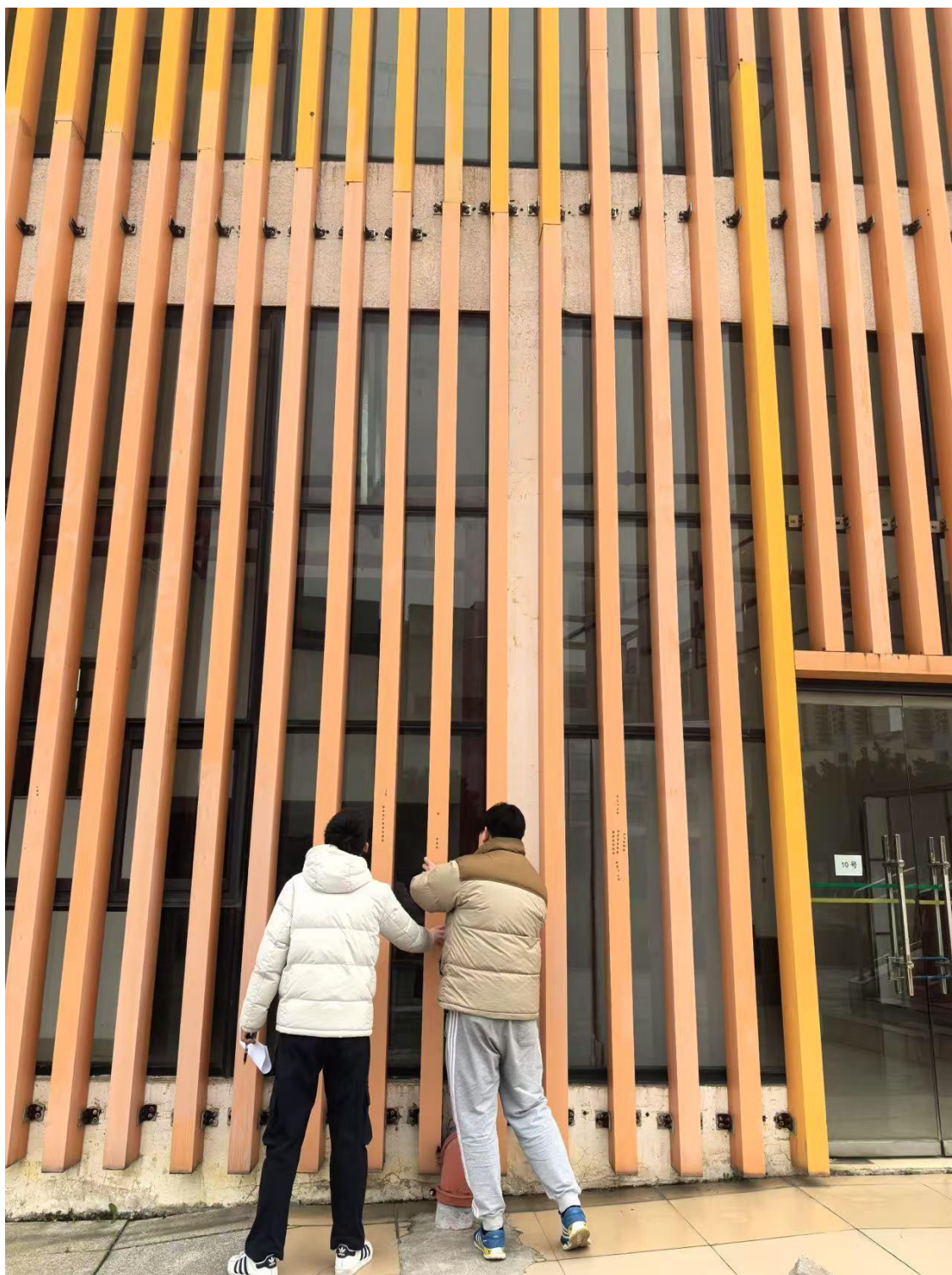
对大学生活动中心外墙装饰进行安全检查
