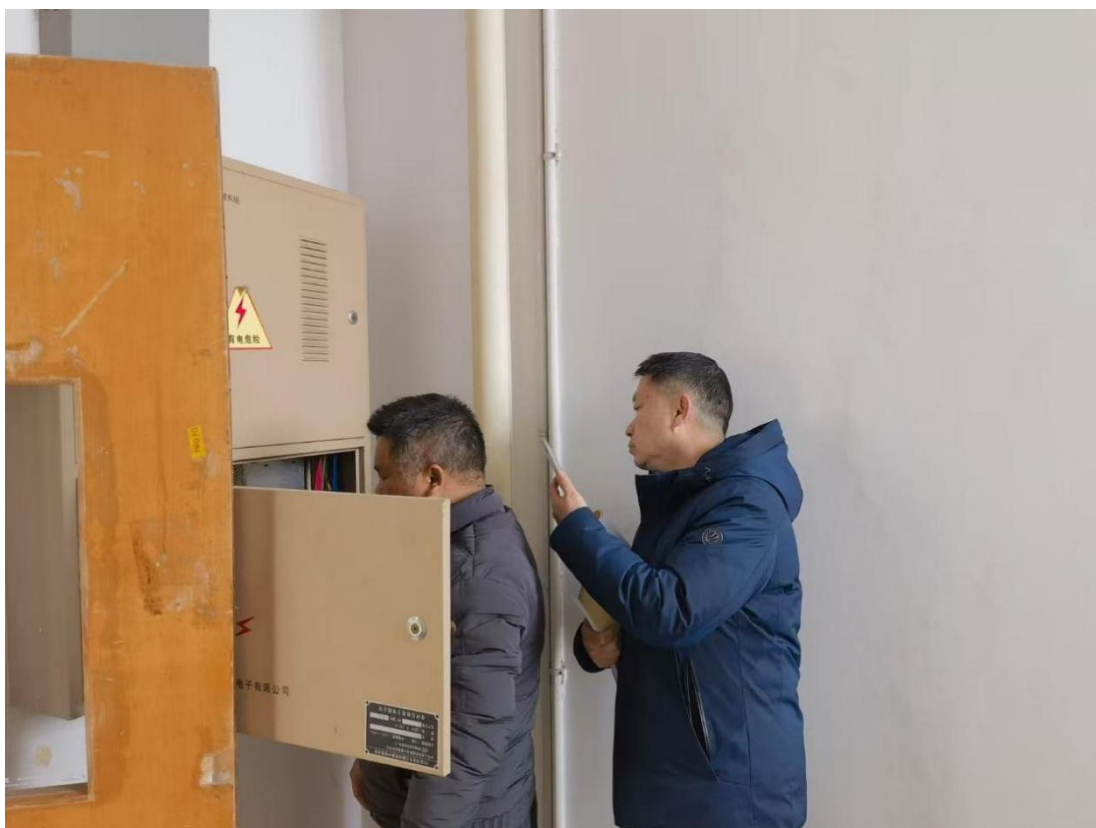
对分体空调设备采购及线路改造安装项目进行现场复核
