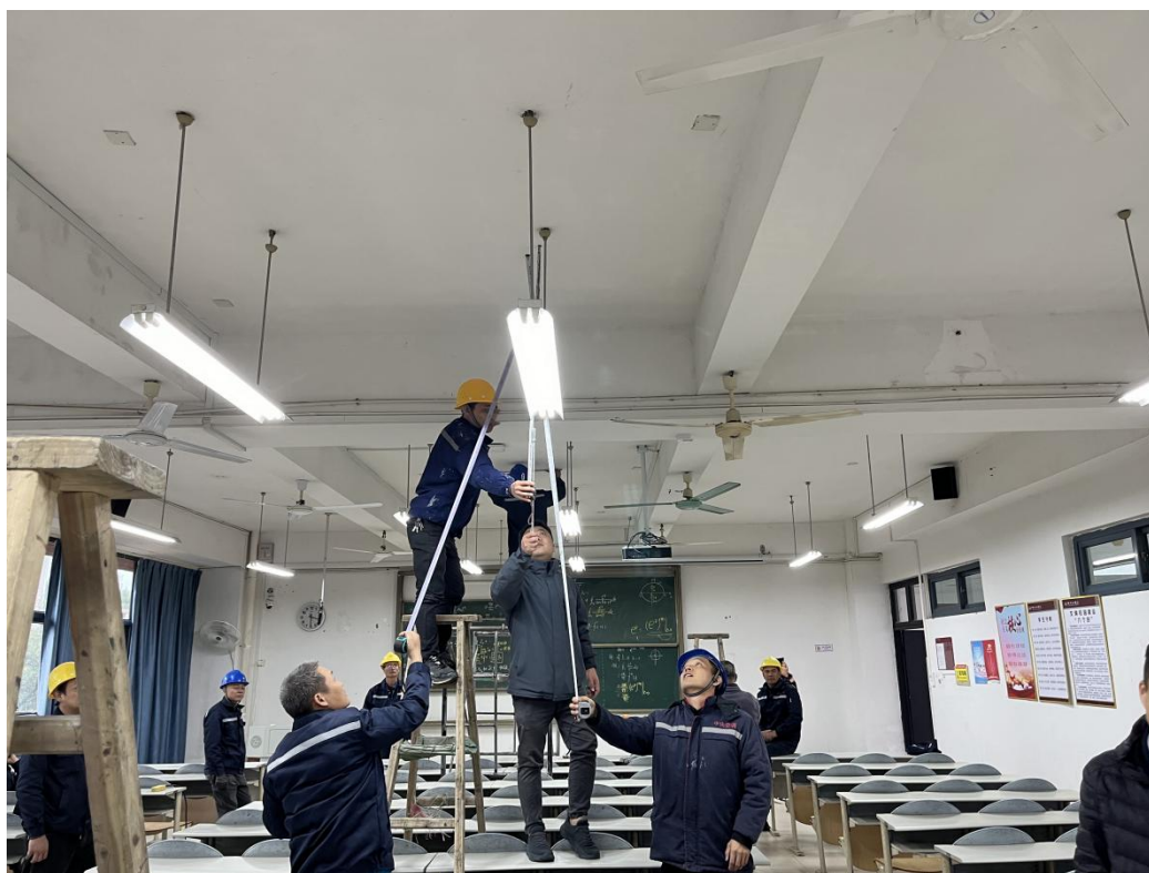
与施工单位确定教室安装空调位置与尺寸
