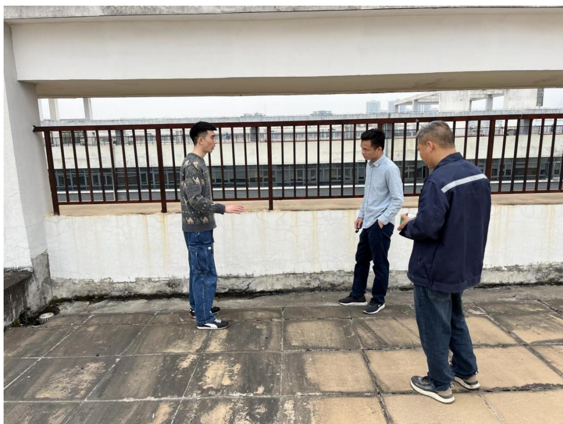
与空调施工方现场确定管路走向
