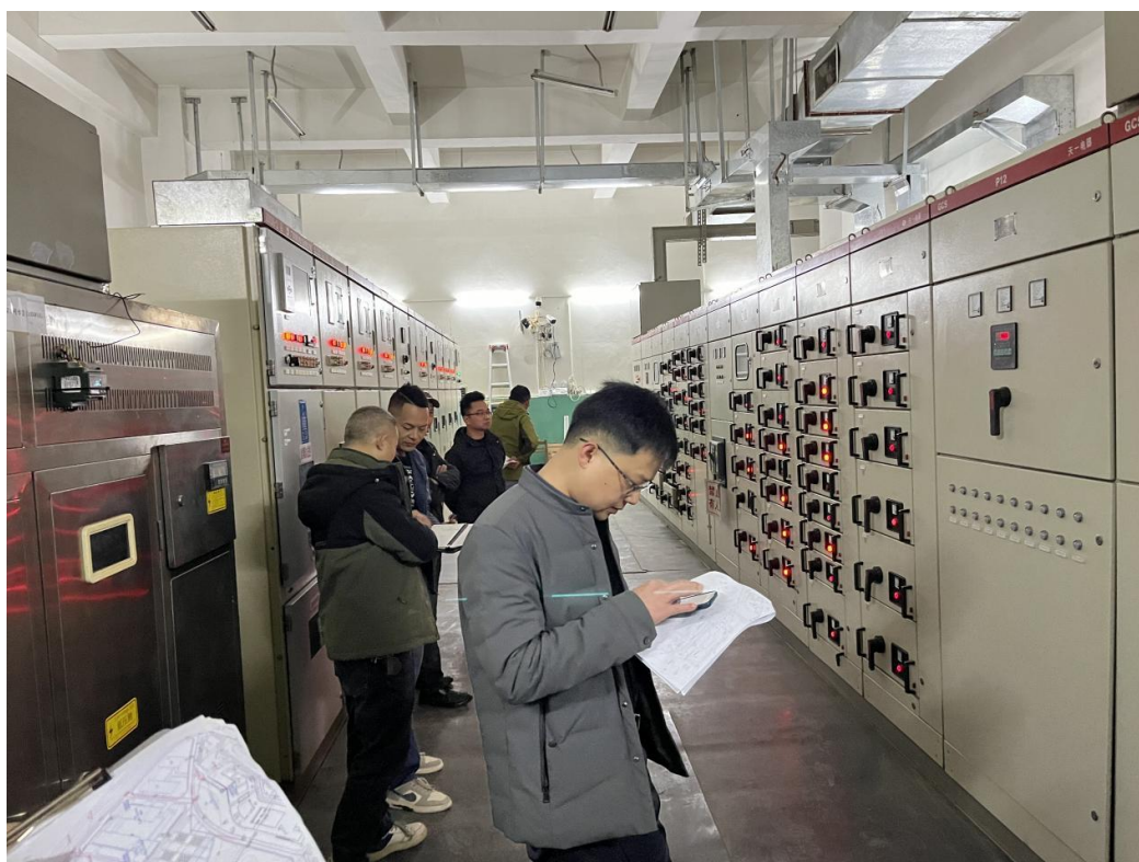
南校区教学区安装空调项目勘察现场
