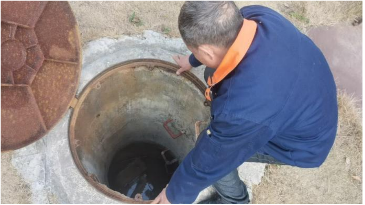
检查排水排污设施
