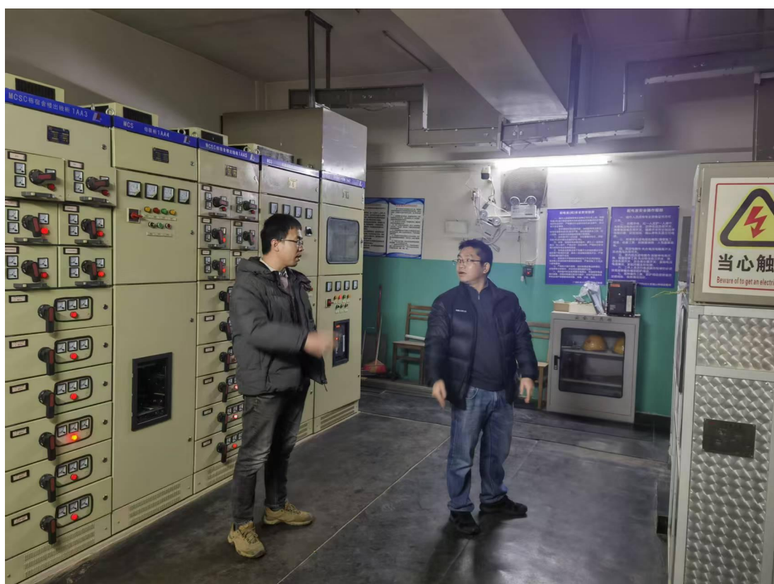
对南校区配电房进行检查
