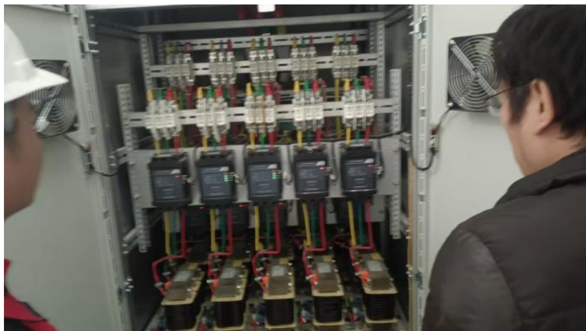
对图书馆高压总配电房配电柜检修及维护
