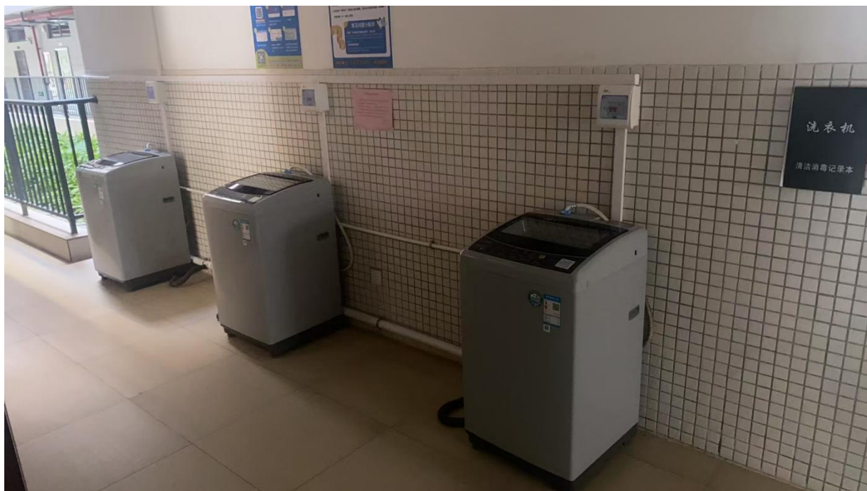
自助洗衣机设备安装完工现场
