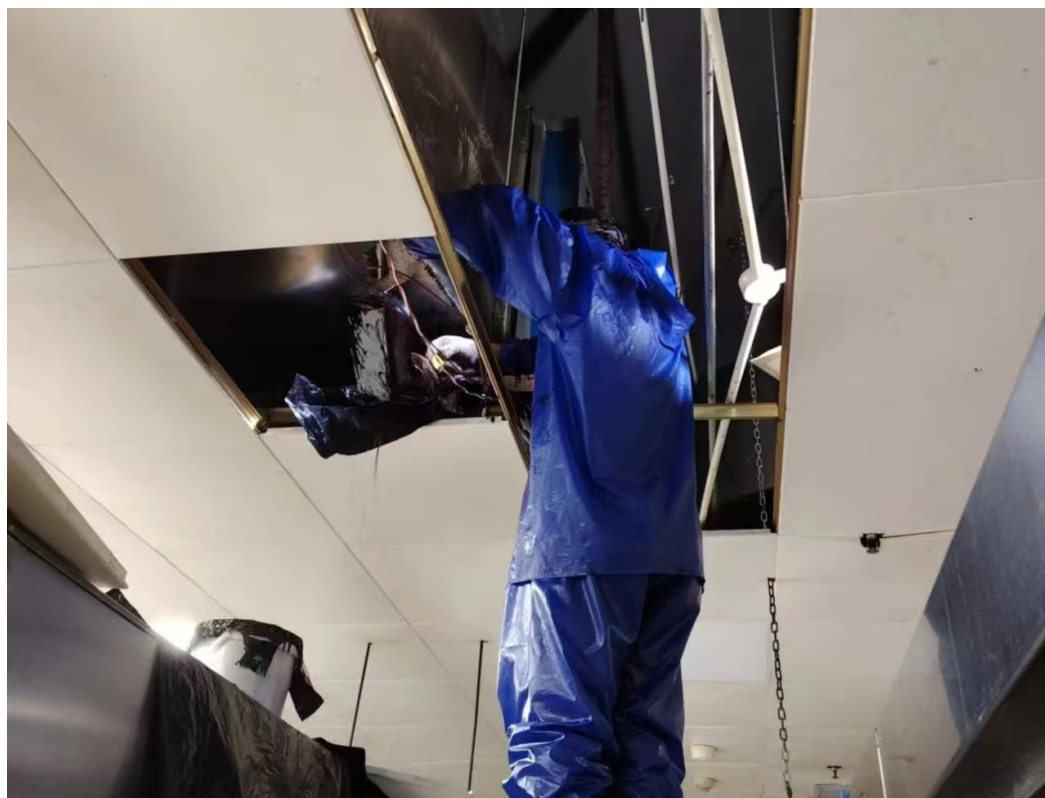
工作人员对油烟管道进行清洗与维护
