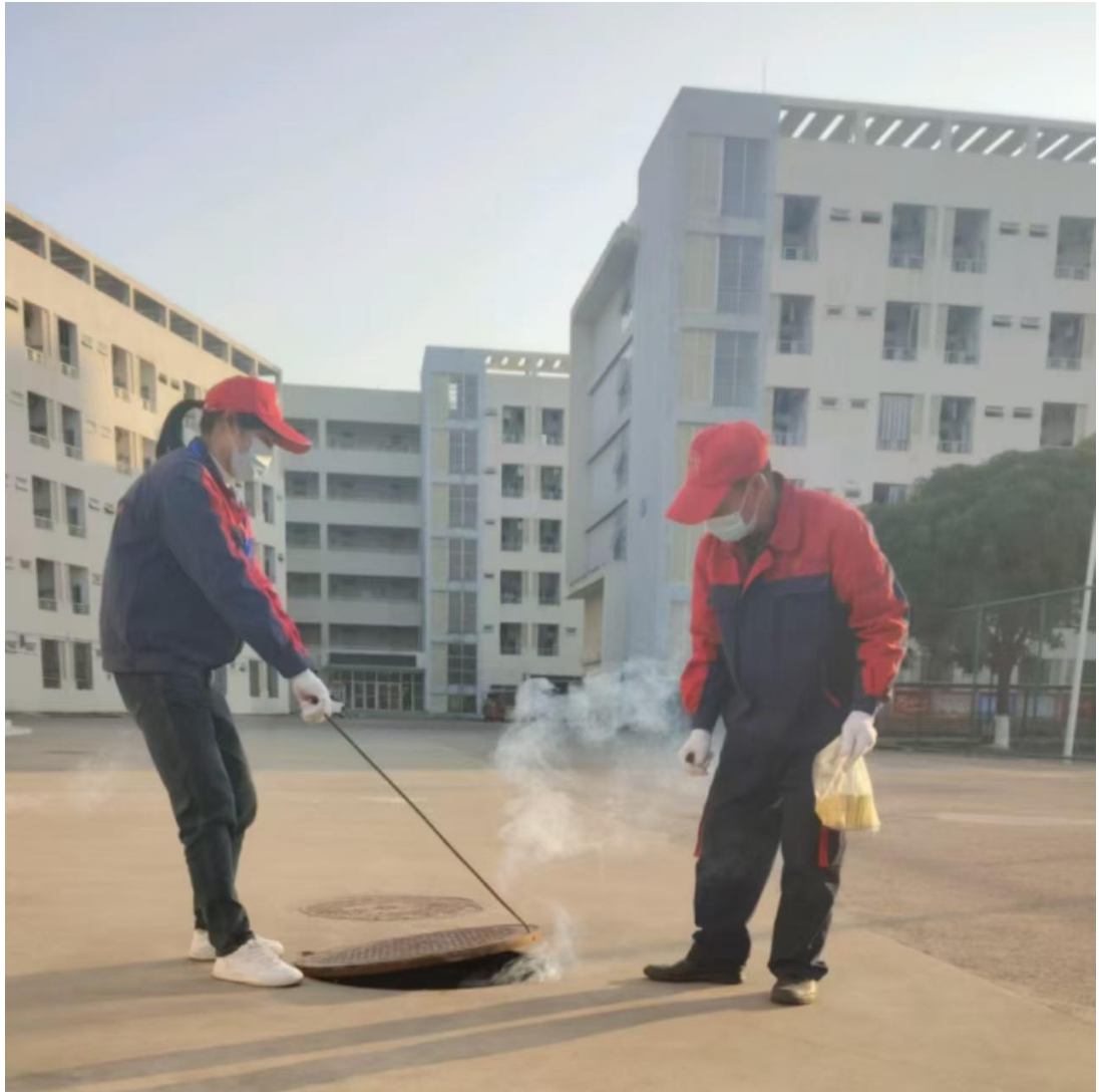
工作人员对下水管道实施有害生物防治工作
