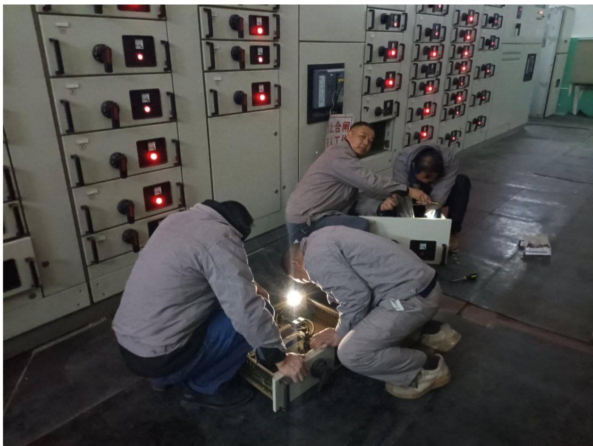
巡查中心配电房
