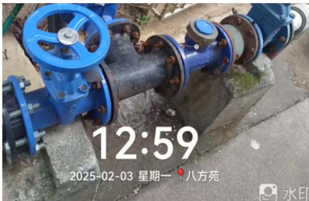
工作人员对水管进行安全检查
