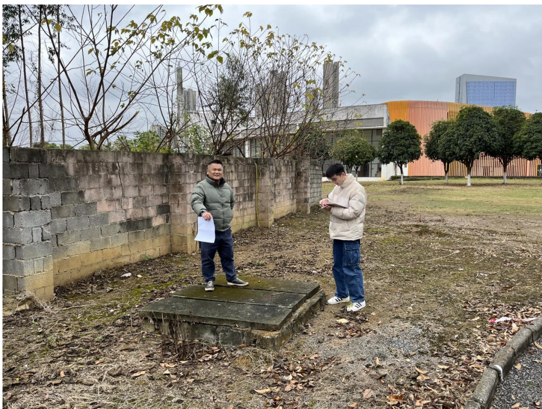
为南校区新建体育馆项目勘察水源接口点
