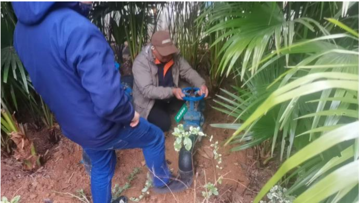
工程师傅保养水阀
