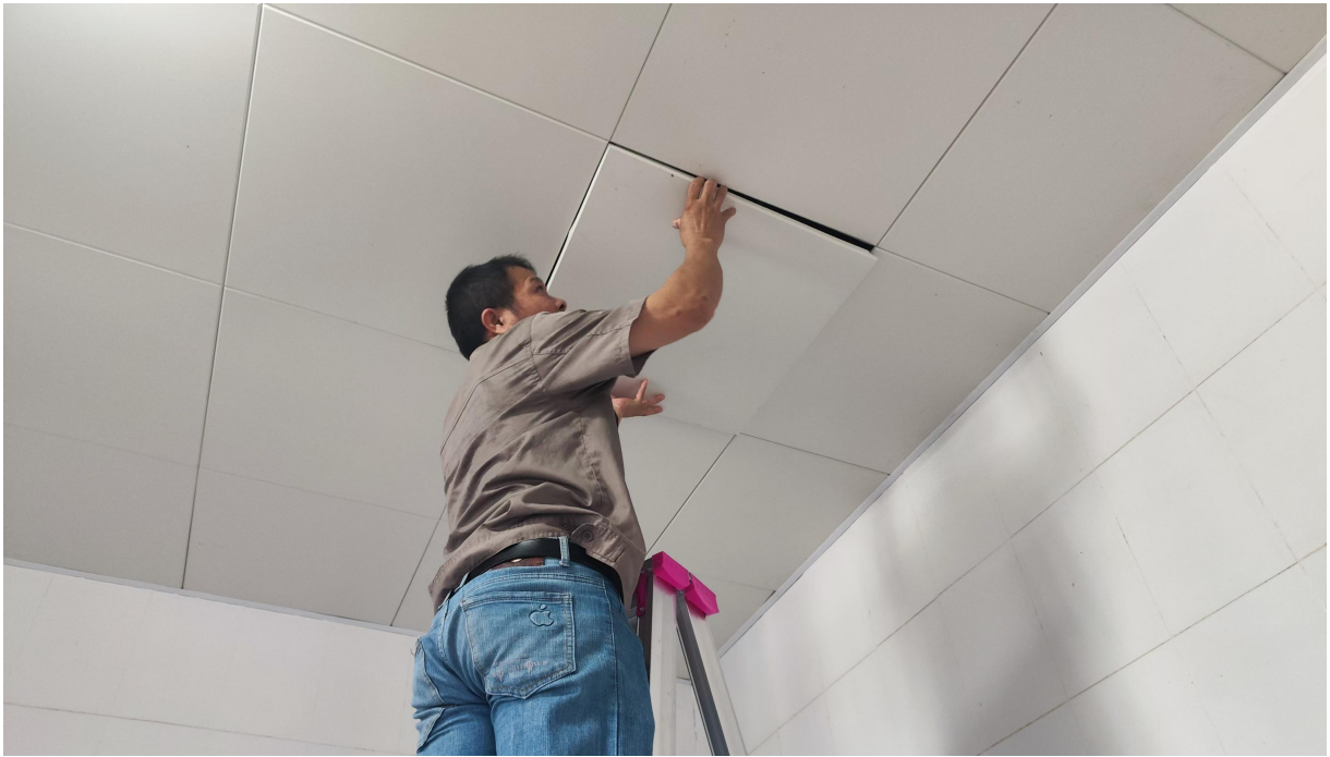
对第三实训楼教卫生间吊顶维护
