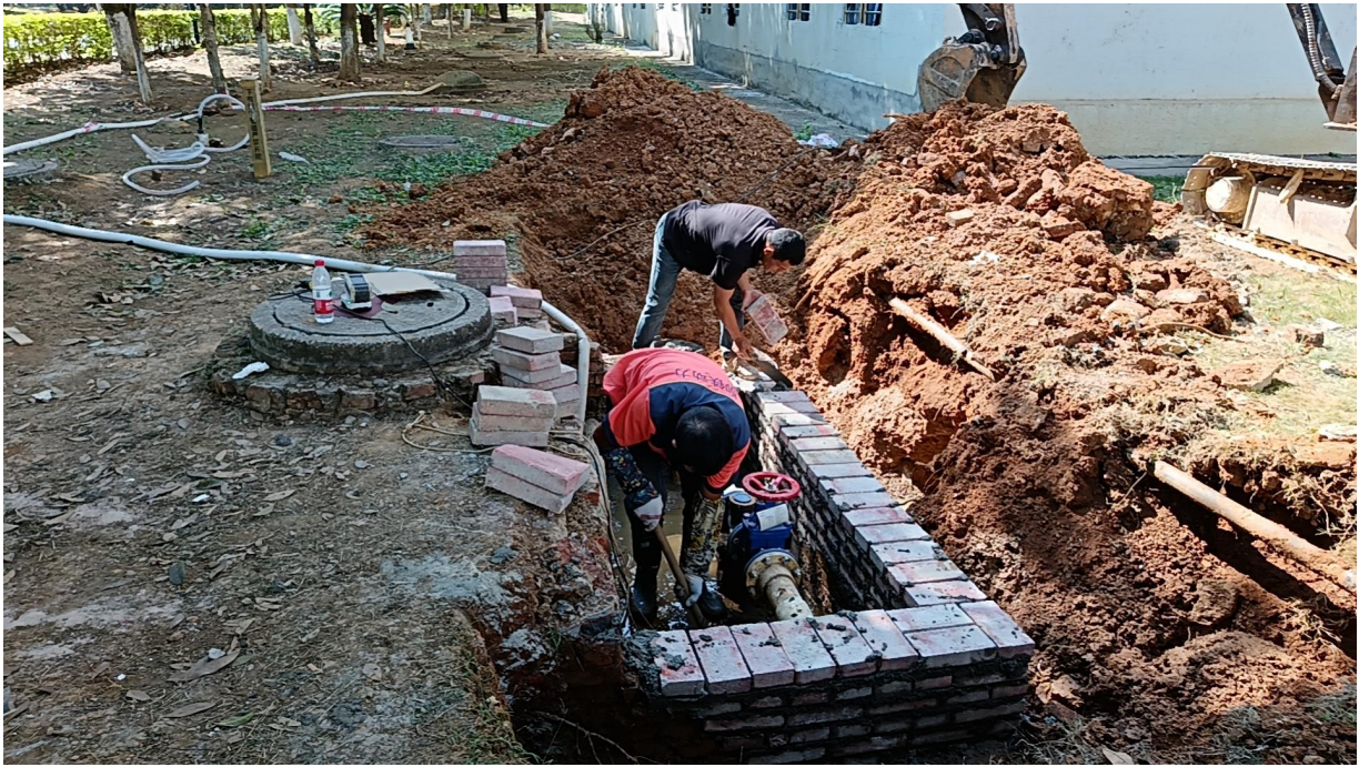
抢修第二栋学生公寓水管
