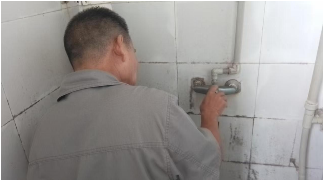
对第二栋宿舍楼淋浴设备维修
