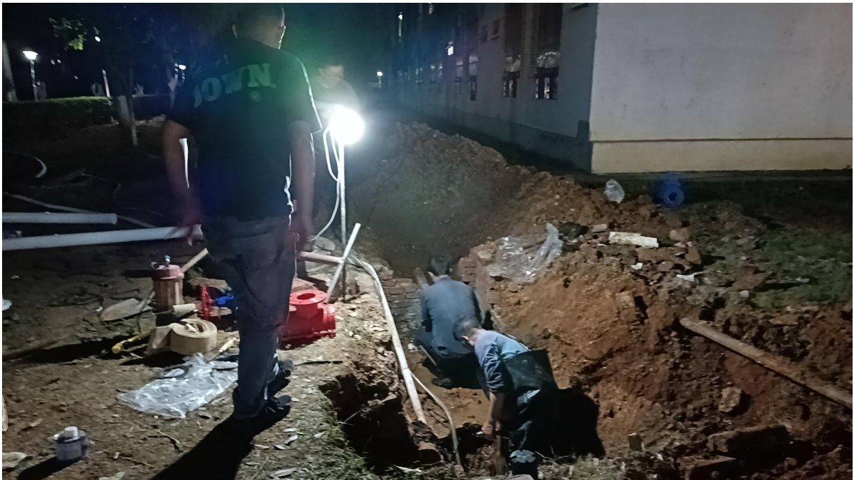
抢修第二栋学生公寓水管
