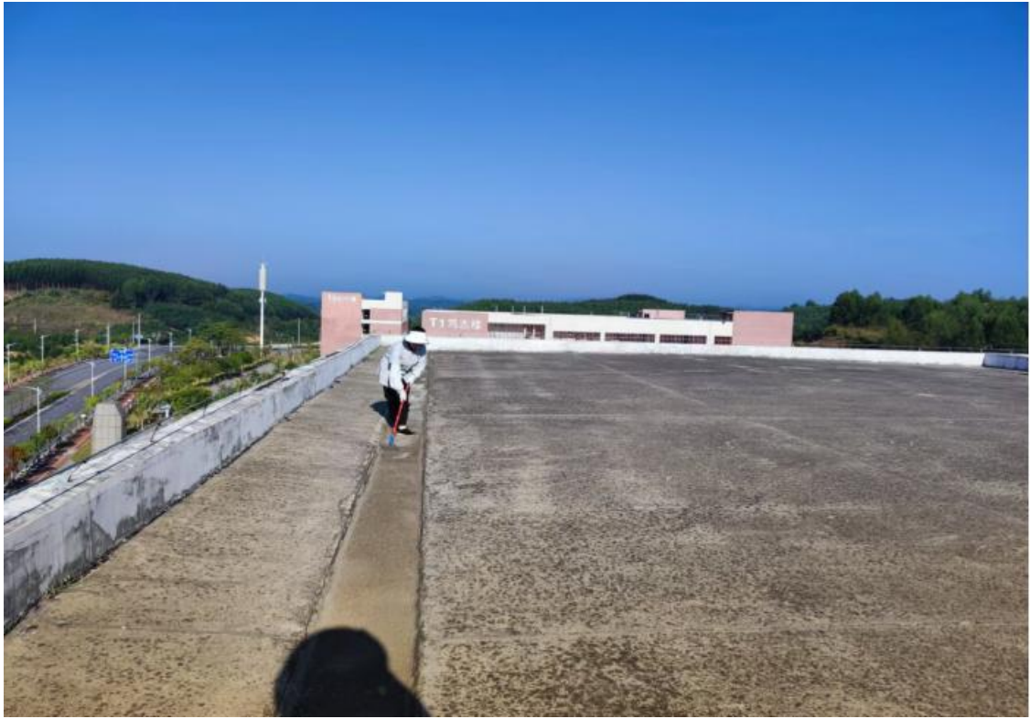
清理宿舍楼顶水沟
