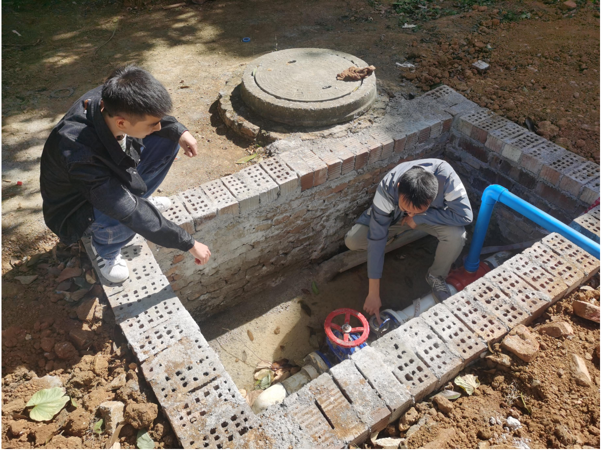
核对工程项目的实际工程量
