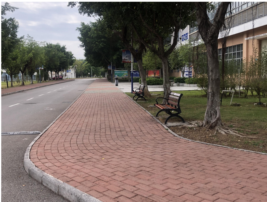
清洗第三实训楼东面人行道透水砖（清理后）
