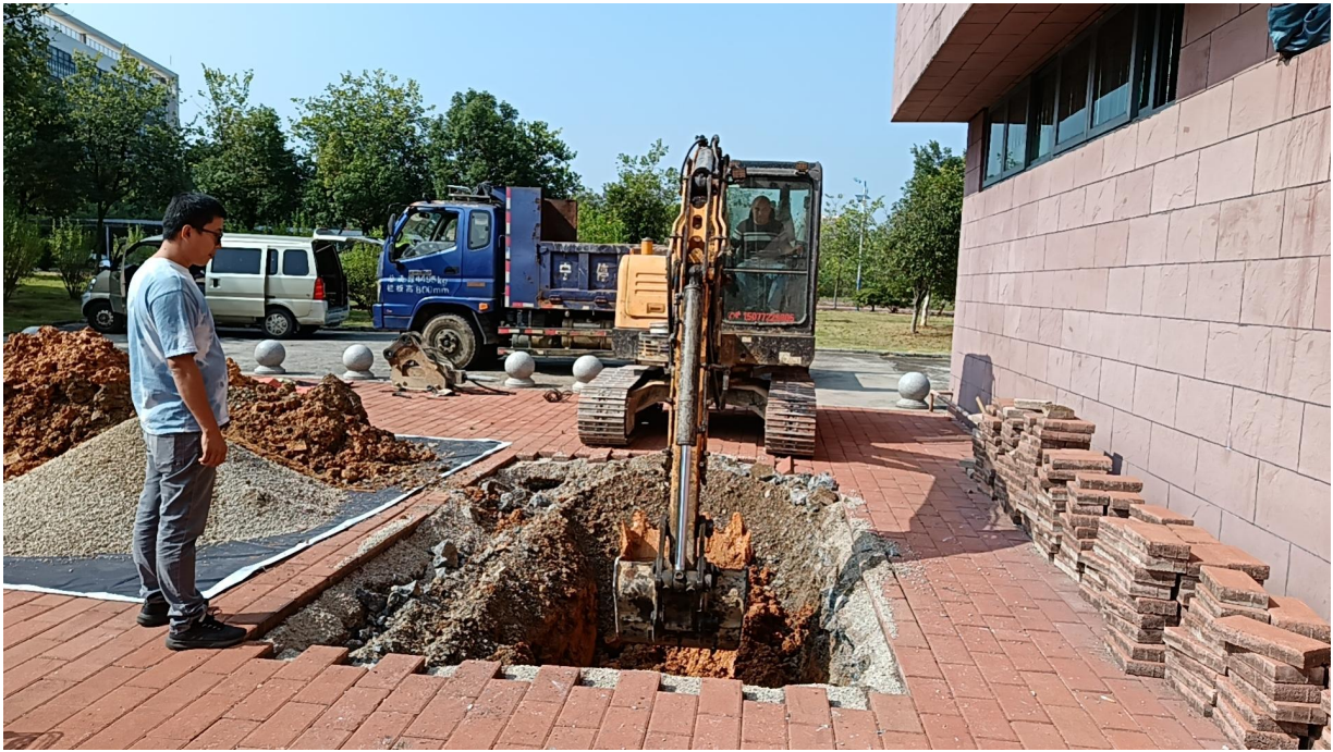
一教西南角漏水点抢修工作
