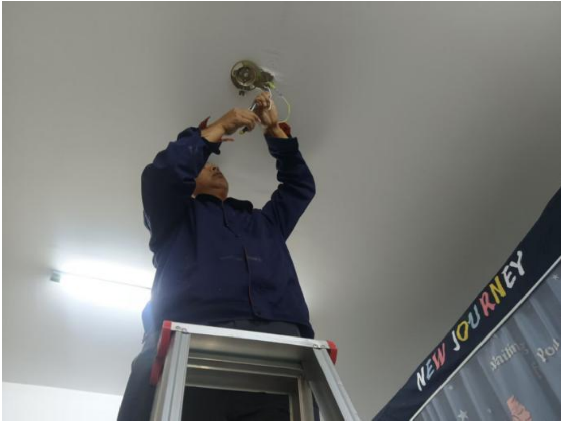
工程师傅维修宿舍风扇
