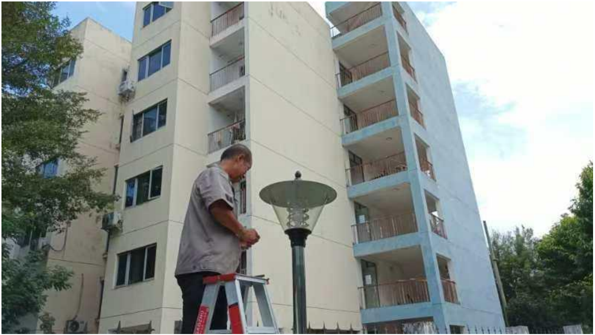
维修第八栋宿舍外围路灯
