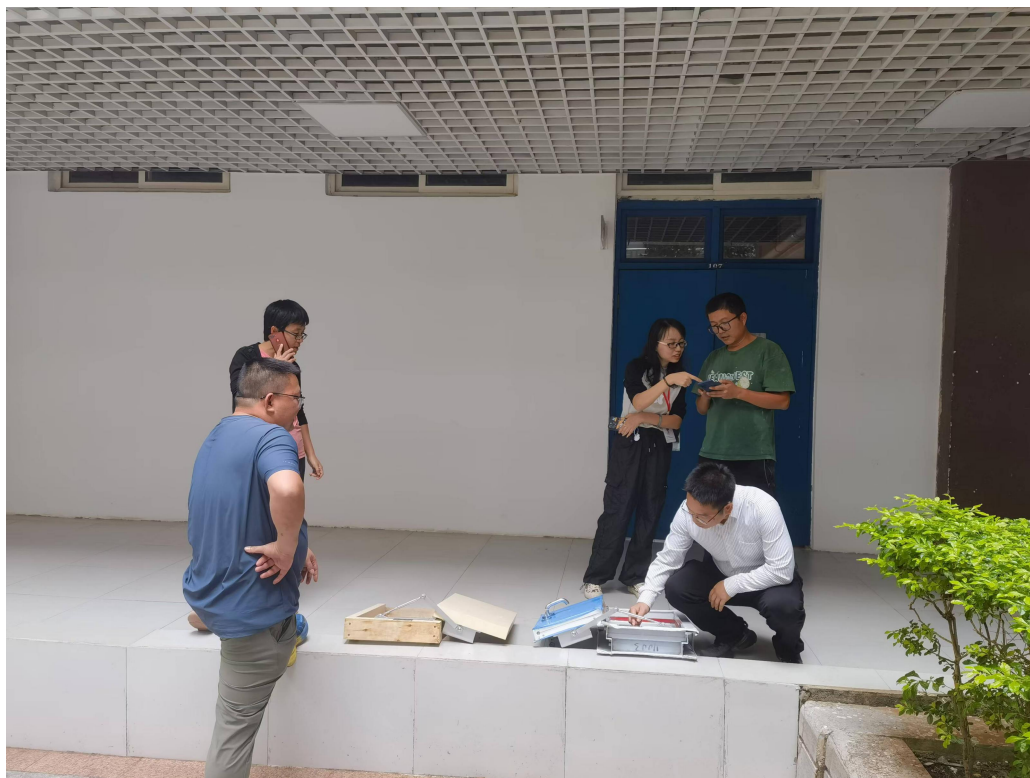
对已完工的腻子施工质量进行确认
