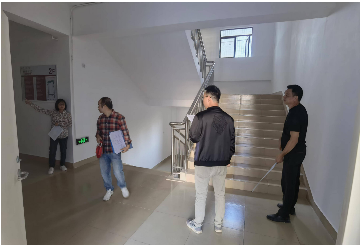
对第二实训楼西侧楼梯间进行验收及工程量收方
