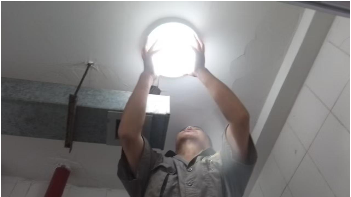
维修宿舍楼卫生间照明灯
