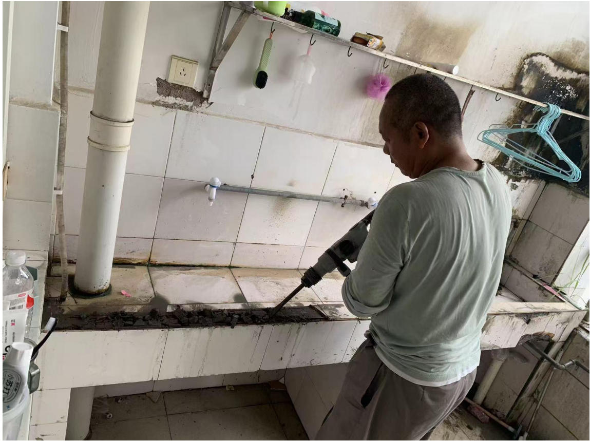
3栋宿舍区洗手池破损修复
