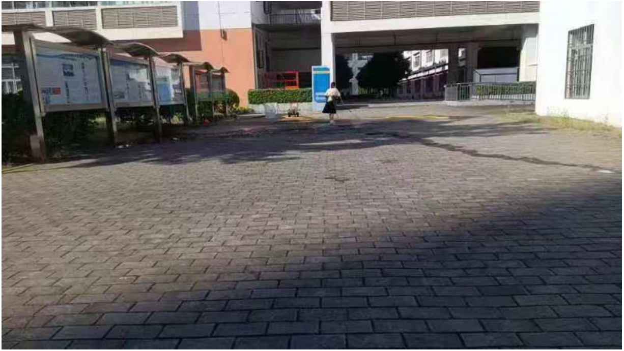
清洗第二教学楼东面人行道透水砖（清理前）
