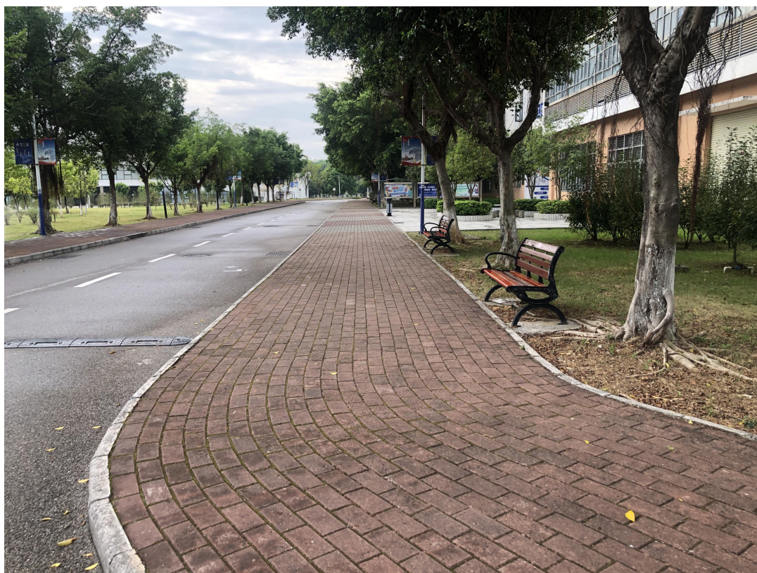
清洗第三实训楼东面人行道透水砖（清理前）
