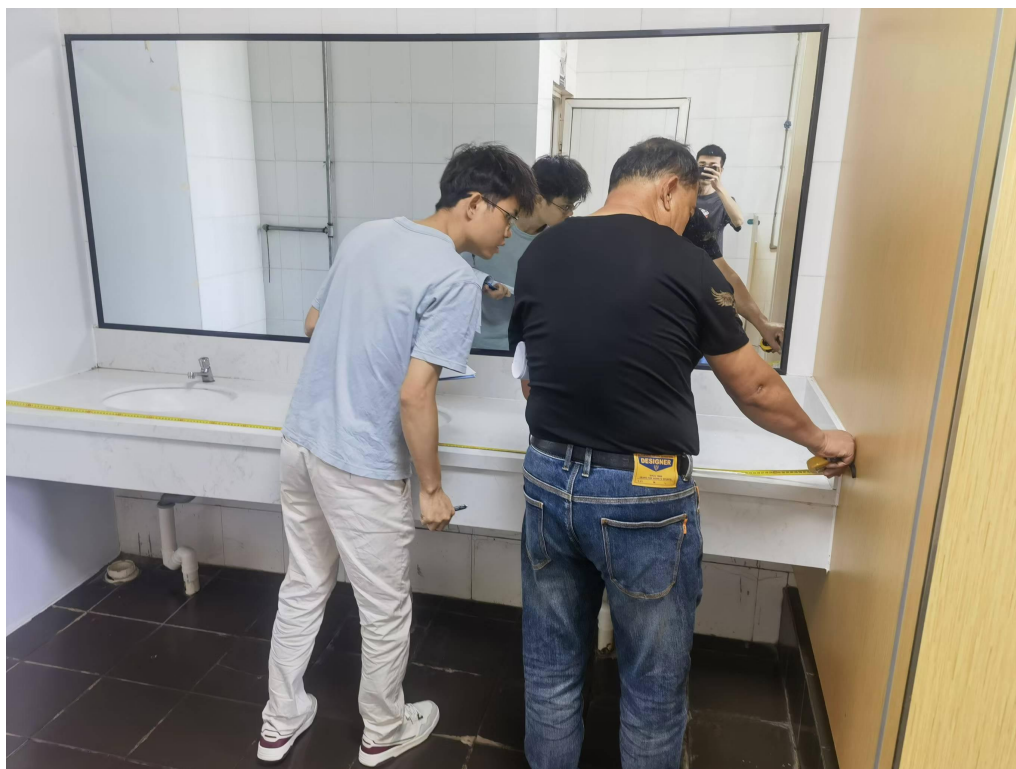
同审计对第一教学楼2-6层卫生间翻新项目进行工程量确认
