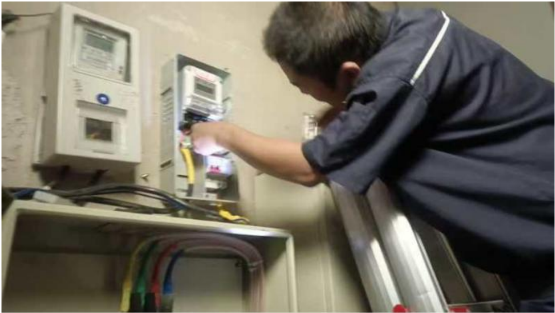
工程师傅更换商铺电表
