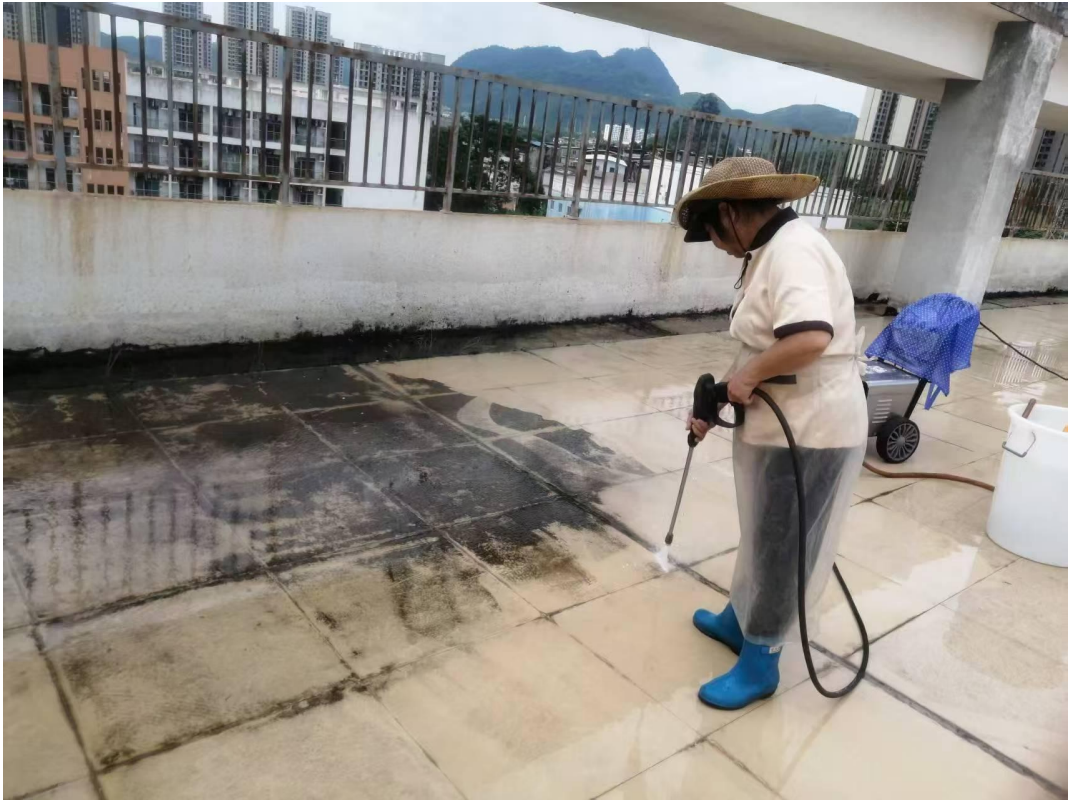
保洁员冲洗天面作业现场
