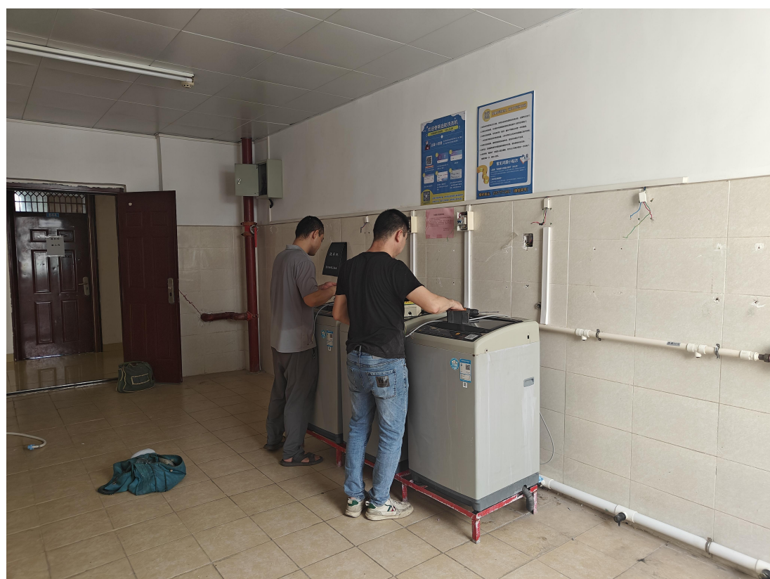
新自助洗衣机商家正在安装新洗衣机
