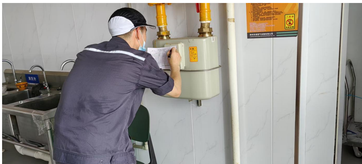
东城燃气公司对一食堂燃气系统展开检查工作
