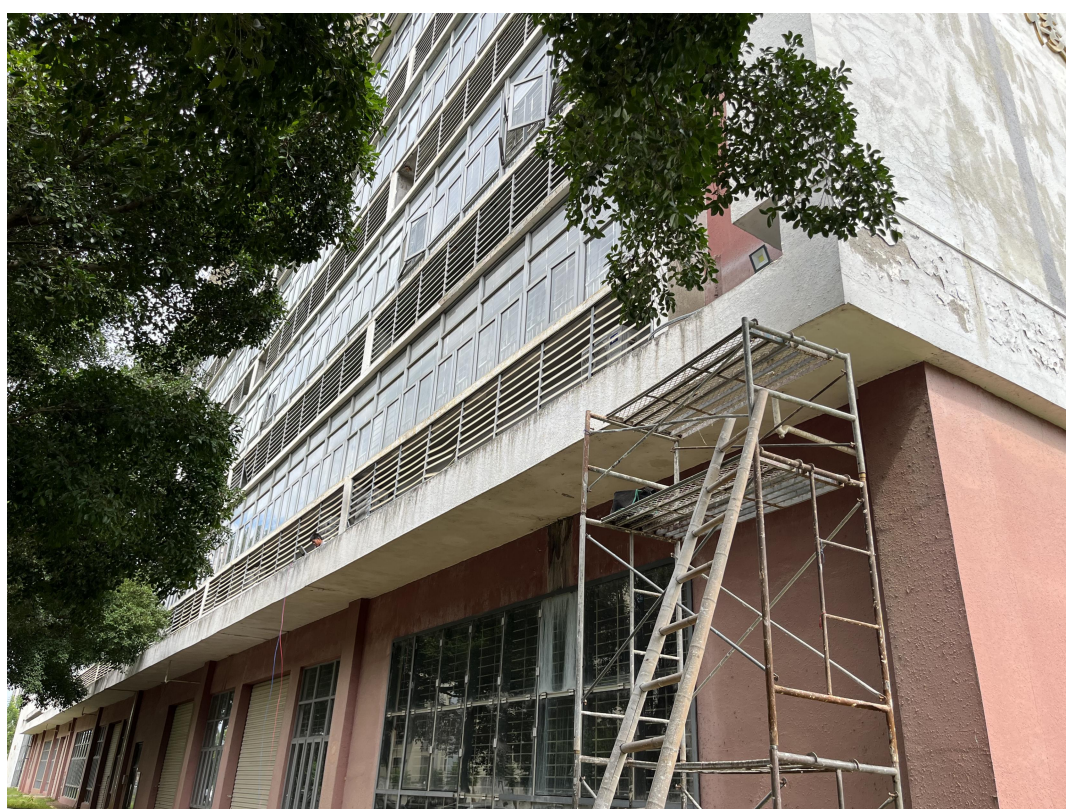
在教学楼二楼凸出平台安装LED灯头
