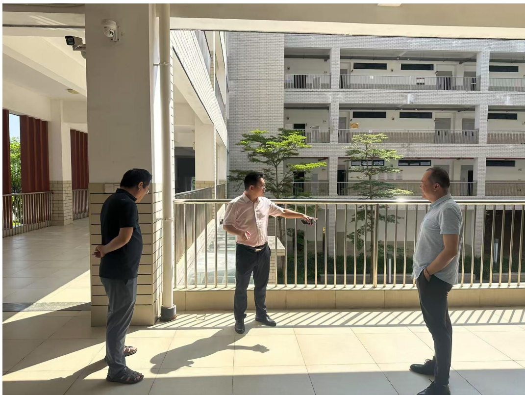
对南北校区教学楼进行四六级考场基础设施专项巡查
