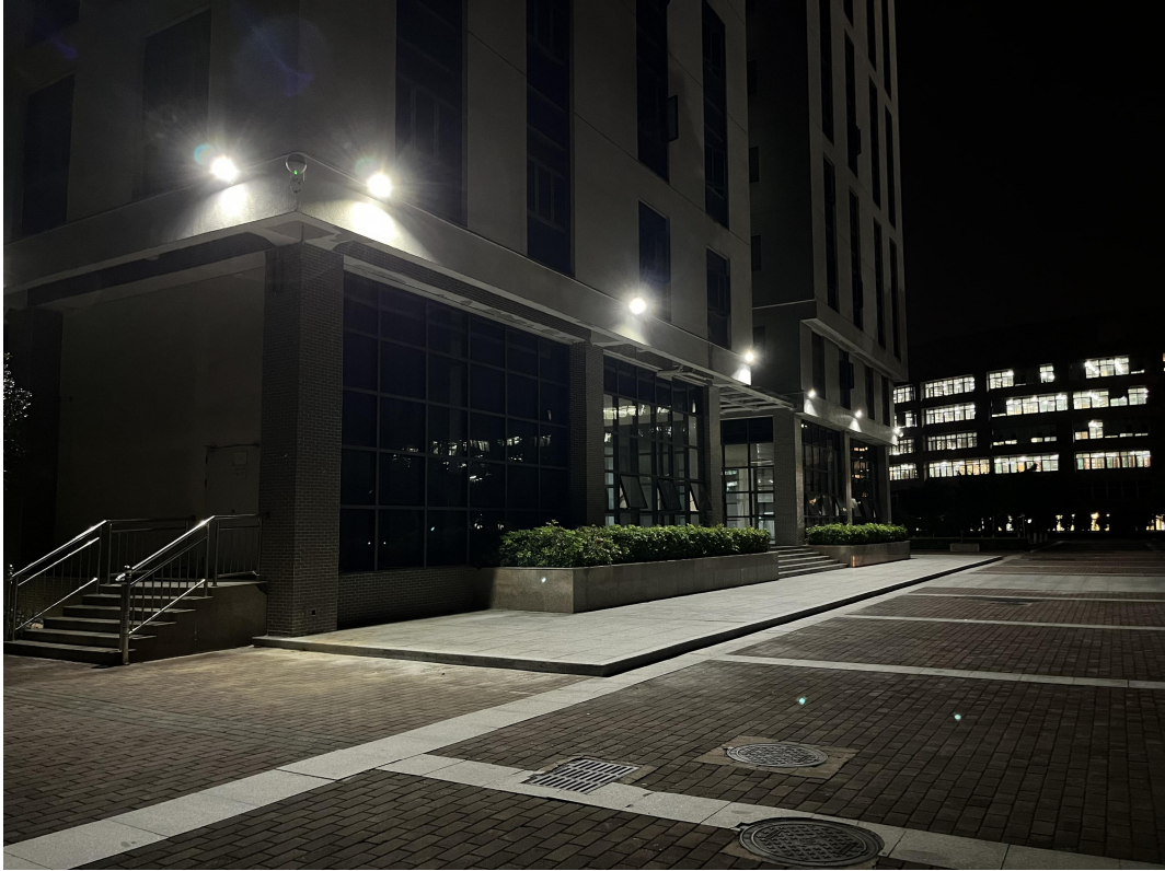
安装后的LED灯头夜间照明效果
