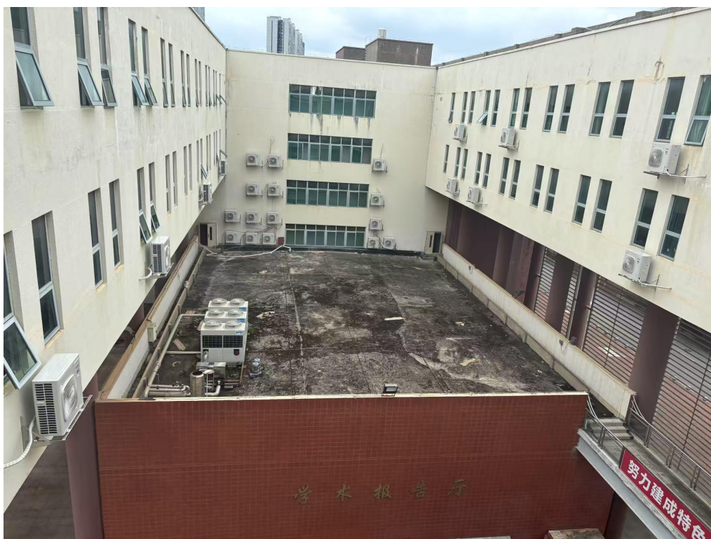
图书馆三楼平台改造前状态
